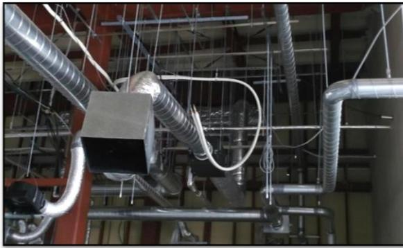
制気口BOXの内側は黒色塗装（ラッカースプレー）し内部を見えなくさせます。
